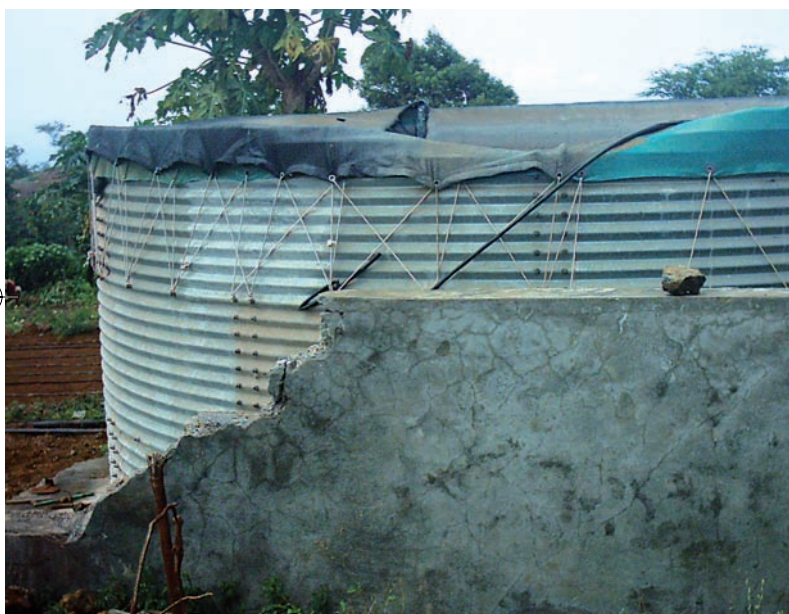
Fig. 8: Cisterna per la raccolta di acqua ad uso irriguo a Patim, Fogo (Foto Capuano, 2008)
