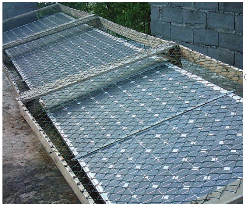
Fig. 4. Pannelli fotovoltaici ad As Hortas, Fogo (Foto Capuano, 2008)
